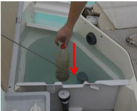
Déposez une bouteille d'eau vide lestée avec du sable dans la cuve de filtration.
