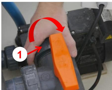
Desserrez l'écrou ① côté vanne 3 voies.
